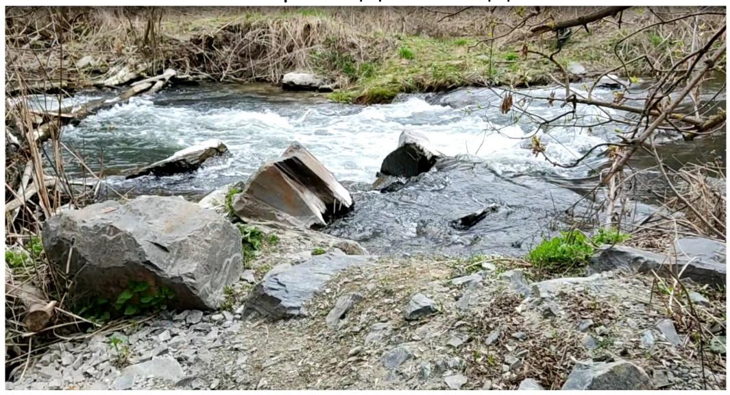
Переход полностью разрушен. Раньше на этом месте был мост, по которому проезжали машины. Переход назывался «3 трубы», потому что вдоль реки были проложены железные трубы метрового сечения, через которые протекала река, а сверху грунт. Предлагаю сделать небольшой металлический пешеходный переход для удобства и безопасности жителей м-на Лукьяновка.
